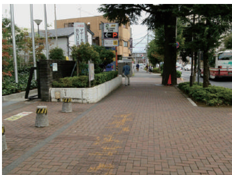
点字ブロックが交差点まで繋がっていない市役所前の歩道（都道）
