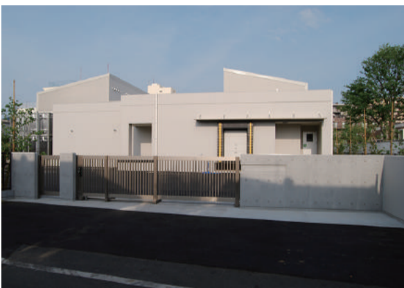
建設中の給食センター (西野川)
